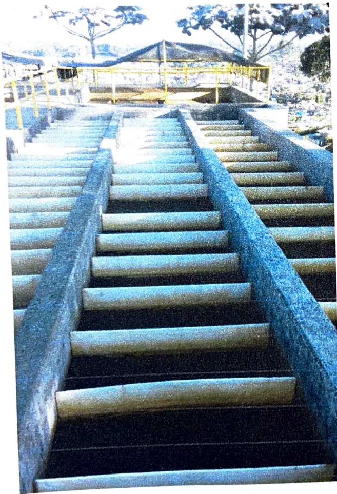
Ilustración 9. Floculador flujo vertical
